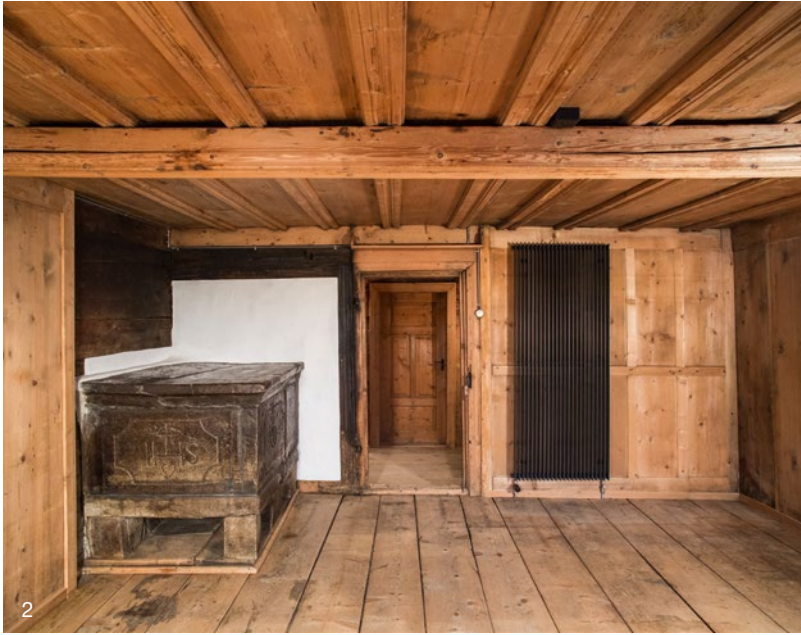
2— Seit der Bauzeit wird das Haus mit zwei schweren Specksteinöfen geheizt.
